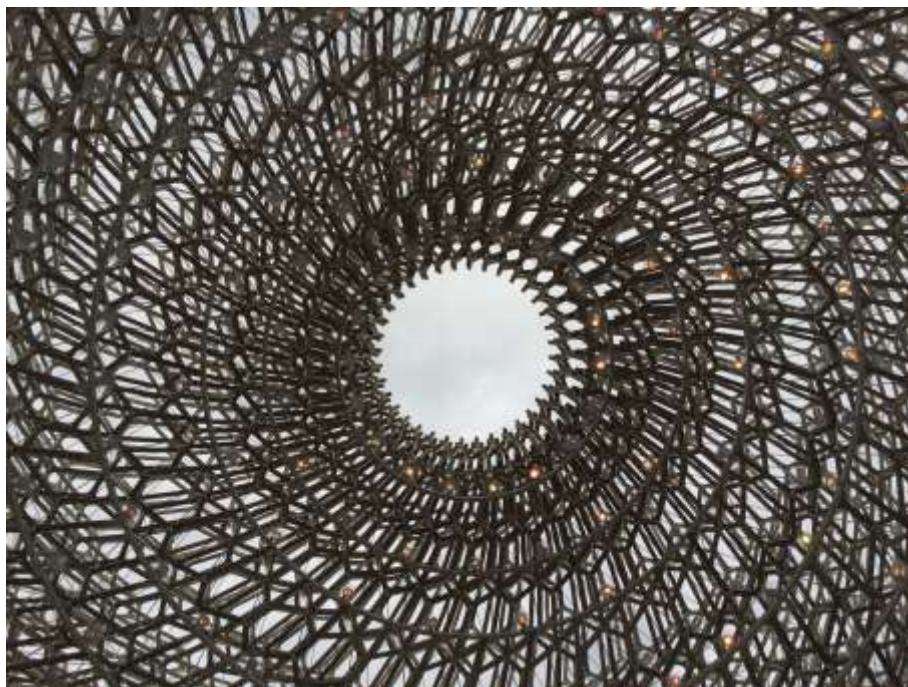
Fig. 7. In occasione dell'Expo di Milano del 2015 l'intero padiglione del Regno Unito era dedicato alle api. La complessa struttura in tubi voleva rappresentare l'interconnessione esistente fra le api di un alveare. Ogni luce, collegata via web ad un singolo alveare collocato nel Regno Unito, mutava in funzione dell'attività delle famiglie, espressa dalle vibrazioni prodotte.
